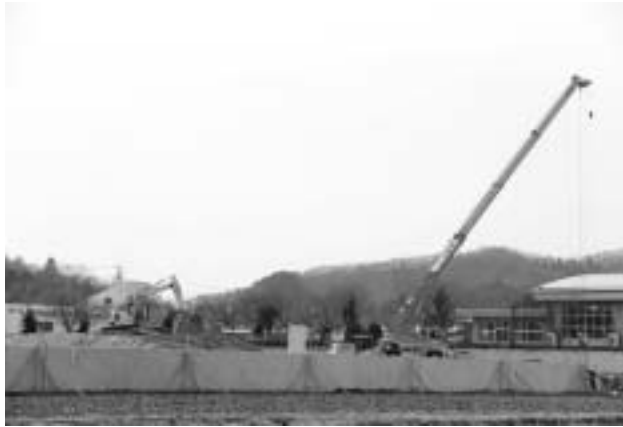
▲ 現地では敷地造成工事が進む (3/18) [施工者：株式会社福南建設]
