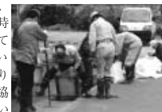
線量低減化の作業の様子
