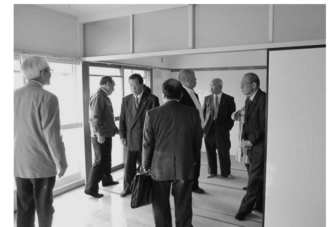
雇用促進住宅 居室の様子
