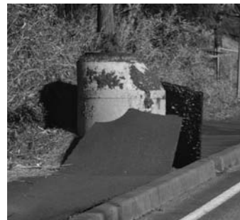
液状化現象(下水マンホール)
