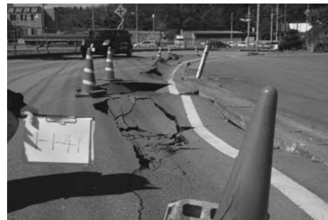
陥没した道路
