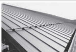
中学校体育館屋根改修工事
