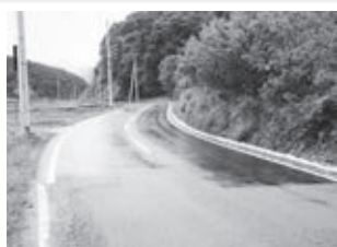
踏瀬・中新城線改良工事
