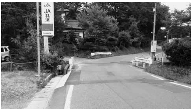
踏瀬町中線道路拡幅工事
