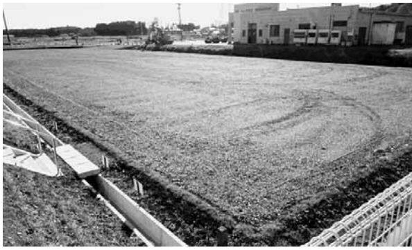
役場駐車場舗装工事
