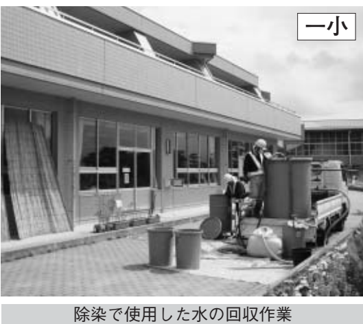
吸引式高圧洗浄機による除染作業
