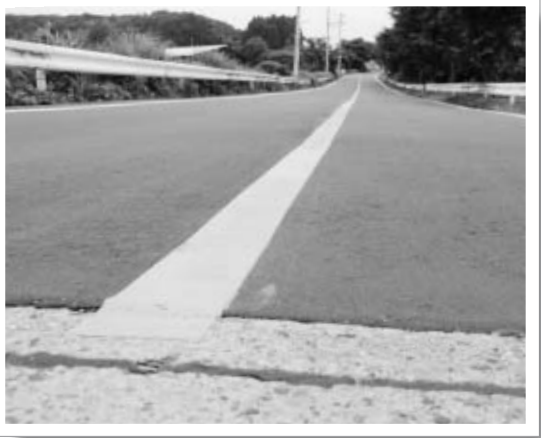
災害復旧工事を終えた村道(新田・矢吹線)日向山地区内
