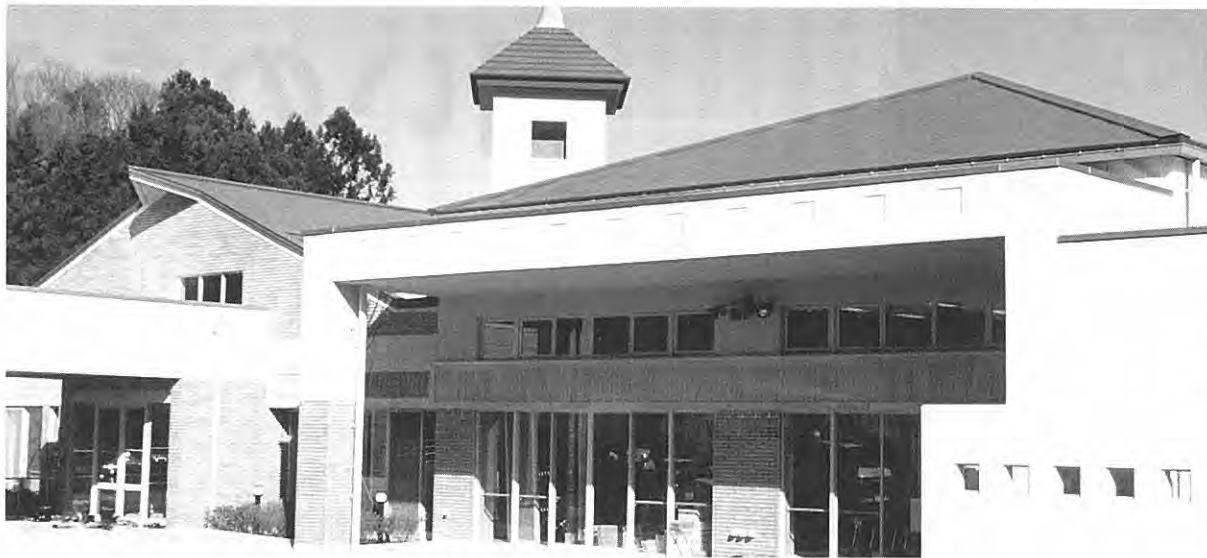
▲保健福祉総合センター（正面玄関）
