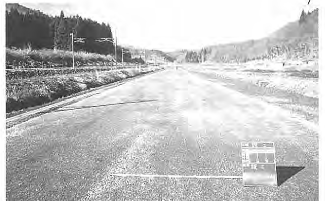
道路改良事業 (新宿・大和田線)
