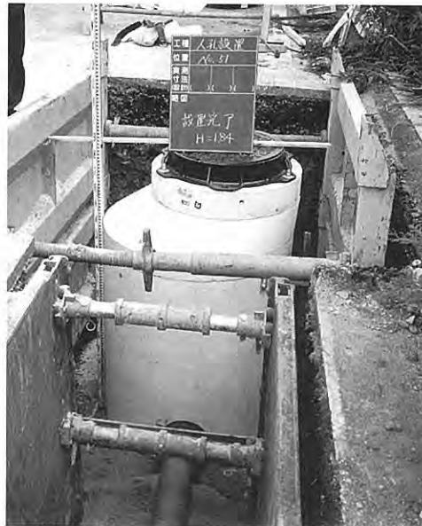
農業集落排水事業 太田川地区 (管路工)
