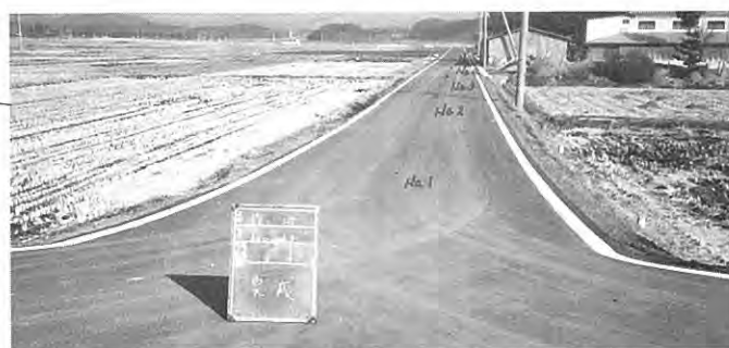
団体営農道整備事業 狐山線（農道整備）
