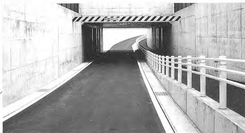
農村基盤総合整備事業 集道6号（集落道整備）
