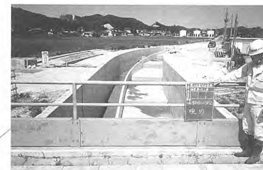
農村基盤総合整備事業(アンダーパス)
