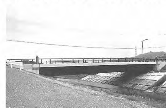
橋梁整備事業(根岸橋)
