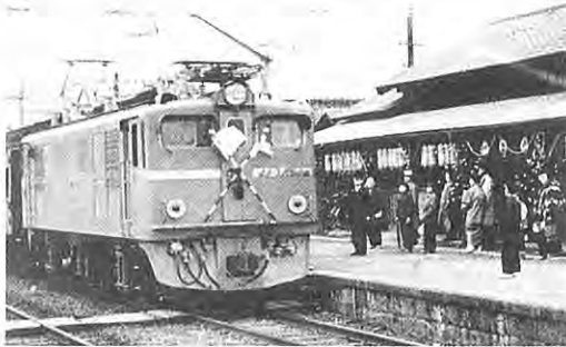
4125●東北本線電化 昭和35年3月30日 白河福島間電化開通式
