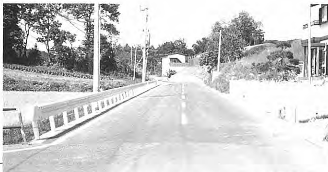
舗装新設改良事業（村道 踏瀬長峯・松倉線）
