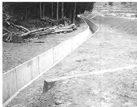
農業用排水路整備事業 (太田川地区)
