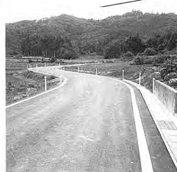
非補助農道整備事業 (堂ノ下地区)
