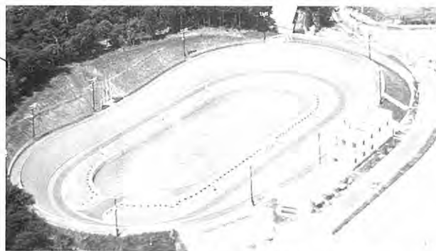
自転車競技場建設（泉崎国際サイクルスタジアム）
