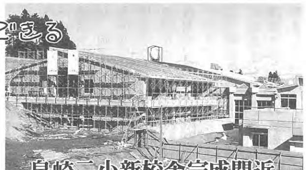
泉崎二小新校舎完成間近
