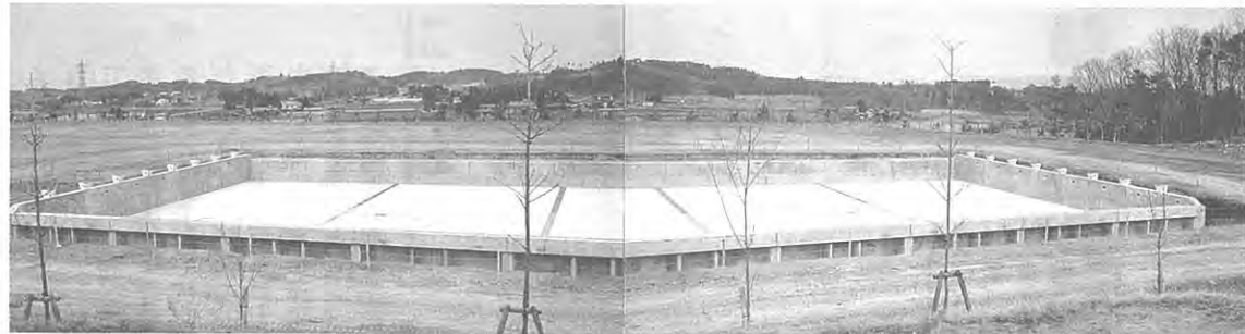
特定地区公園建設事業（さつき公園・プール建設）
