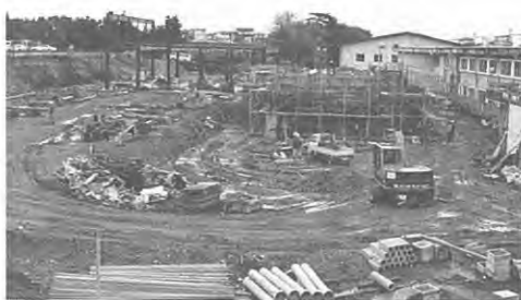
新增改築工事の進む校舎
