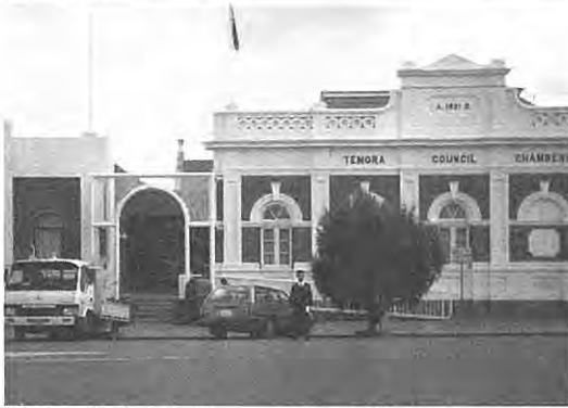
(テモラ町舎：シドニーより西へ約350km)
