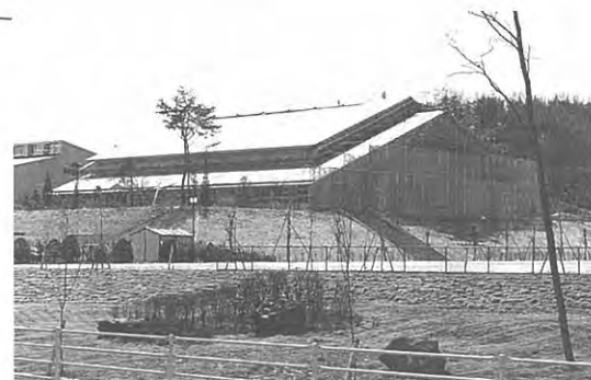
中学校体育館建設事業
