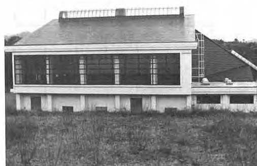
新農業構造改善事業 農業者トレーニングセンター建設 (桧内地区)
