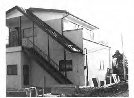
第三分団二部屯所新築(宿館地区)
