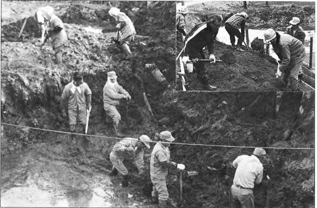
〈北平山地区住民による手づくり防火水槽工事〉
