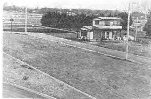
＜宅地造成工事の全景＞
