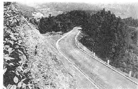
＜立派に完成した治山関連参道取付道路＞
