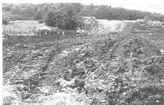
着工した幼稚園敷地造成工事
