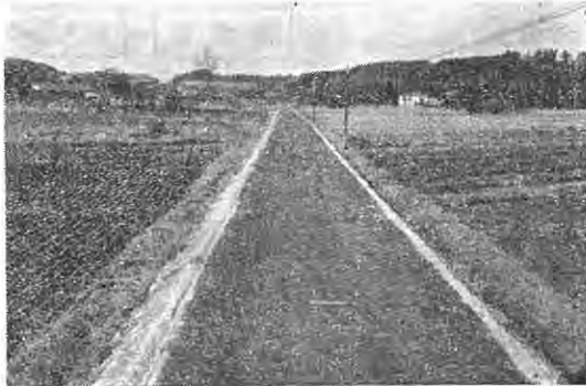
△完成された農道十軒前線▽
