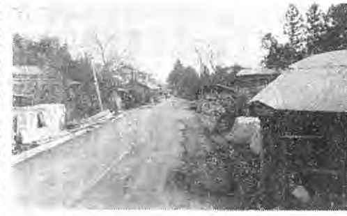
【舗装された館—新宿線(役場裏より)】
