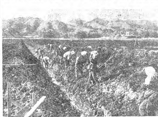
写真完成を目ざして工事を急ぐ 関平地区工事現場
