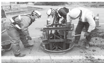
農業集落排水処理事業機能強化対策工事（富久保地区）
