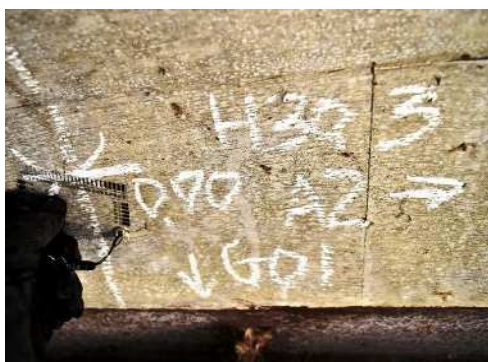
49. 横穴歩道橋：鋼I桁橋 (橋長：34.95m、1990年竣工) 床版下面の遊離石灰を伴うひびわれ (最大幅0.7mm)
