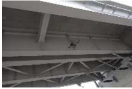
ドローンによる桁下の点検
