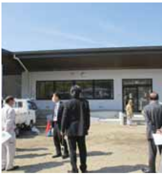
西郷村給食センター建設
