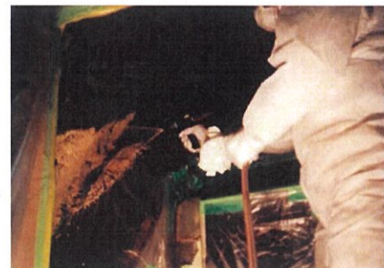
修復作業の様子
