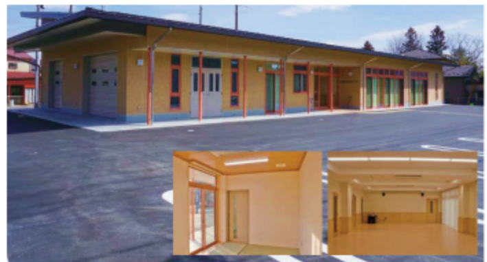
平成 29 年開所の泉崎村防災センター
