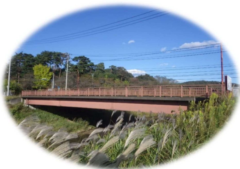
横穴歩道橋 (1990年竣工)
