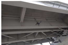
ドローンによる桁下の点検
