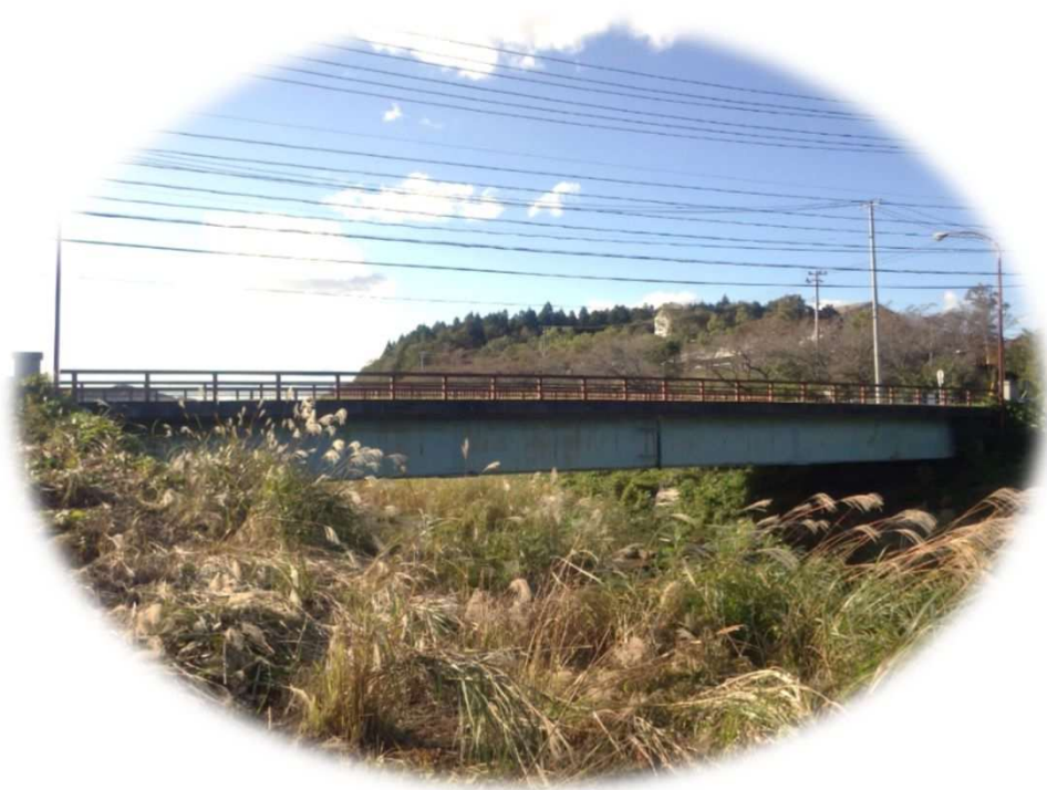
横穴橋 (1972年竣工)
