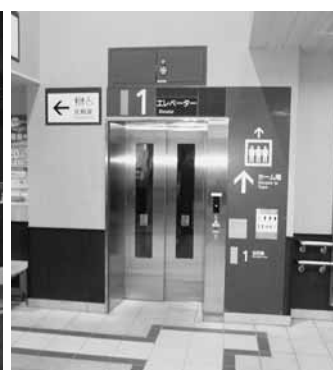
松島海岸駅エレベーター
