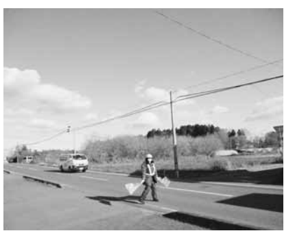
井戸沼理髪店付近の工事
