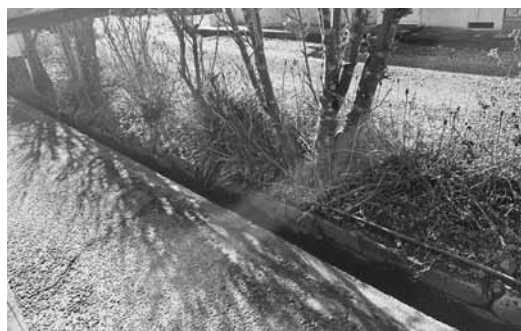
上町点滅信号美容室付近の側溝
