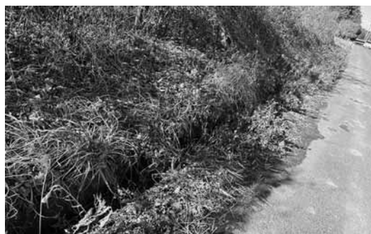
天王台下付近の側溝
