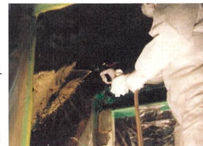
修復作業の様子
