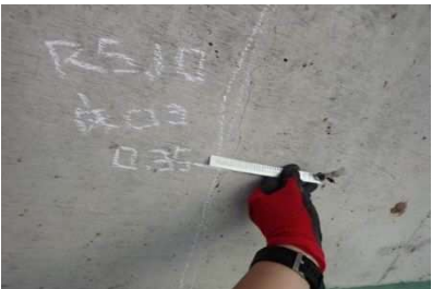
床版下面のひびわれ（幅0.35mm）
