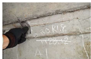
頂版下面のひびわれ（幅0.8mm）
