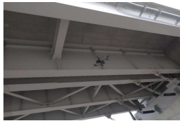
ドローンによる桁下の点検
