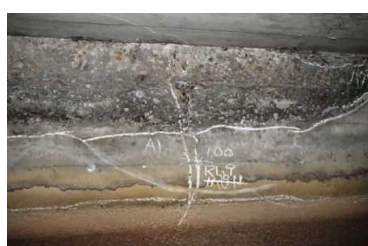
下部工のひびわれ(幅1.0mm)、剥離
