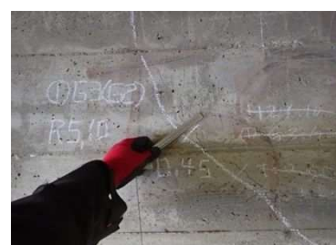
主桁のひびわれ(幅0.45mm)
