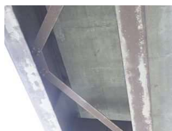
床版下面のひびわれ(幅0.7mm)
