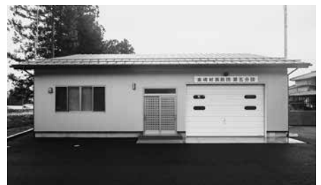
完成した新屯所
