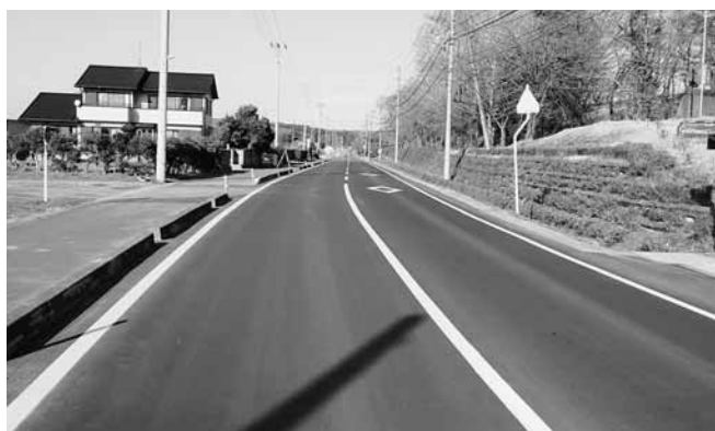
新田矢吹線舗装補修工事
