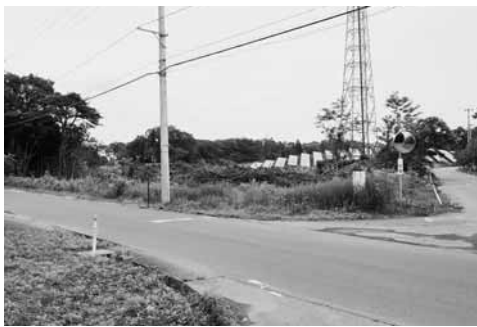
柵内裏伐採箇所
