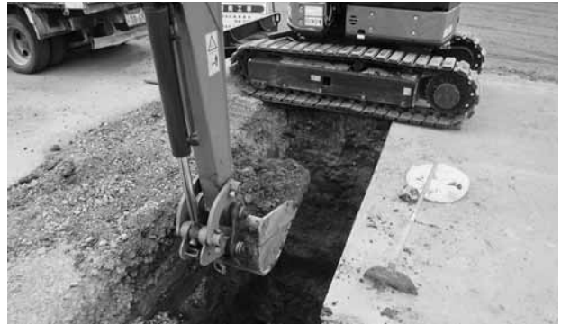
村内にある石綿管
